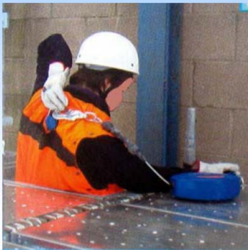
ASSICURARE L'ARROTOLATORE ALL'IMBRACATURA DI SICUREZZA
