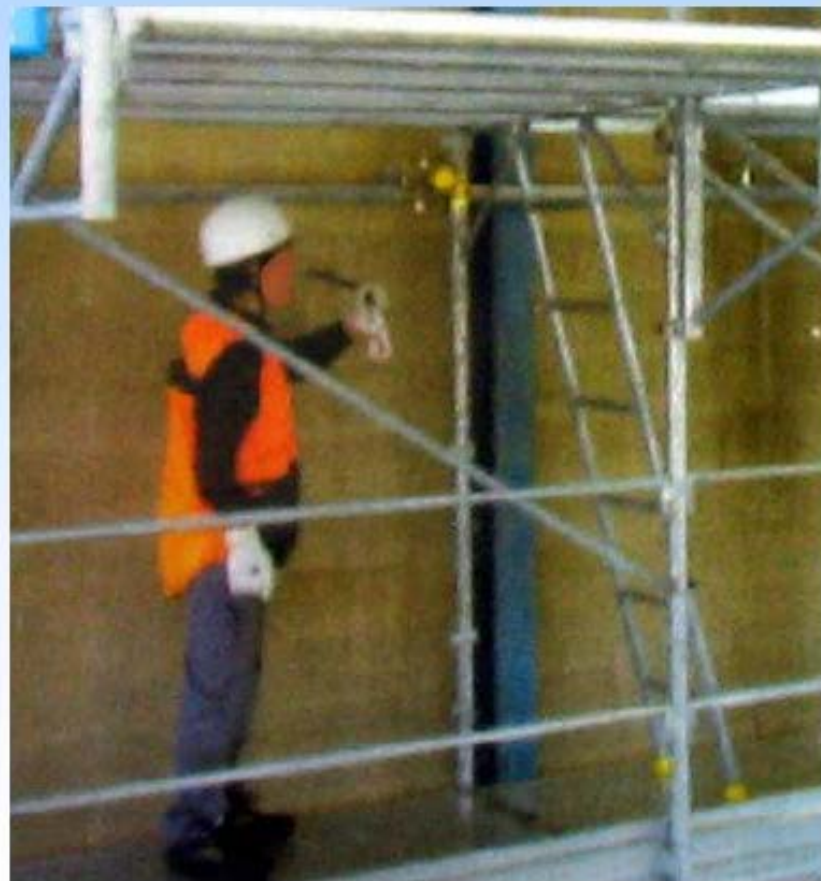
SCAVALLARE TUTTI GLI SPINOTTI DEI MONTANTI DEL LIVELLO SUPERIORE
