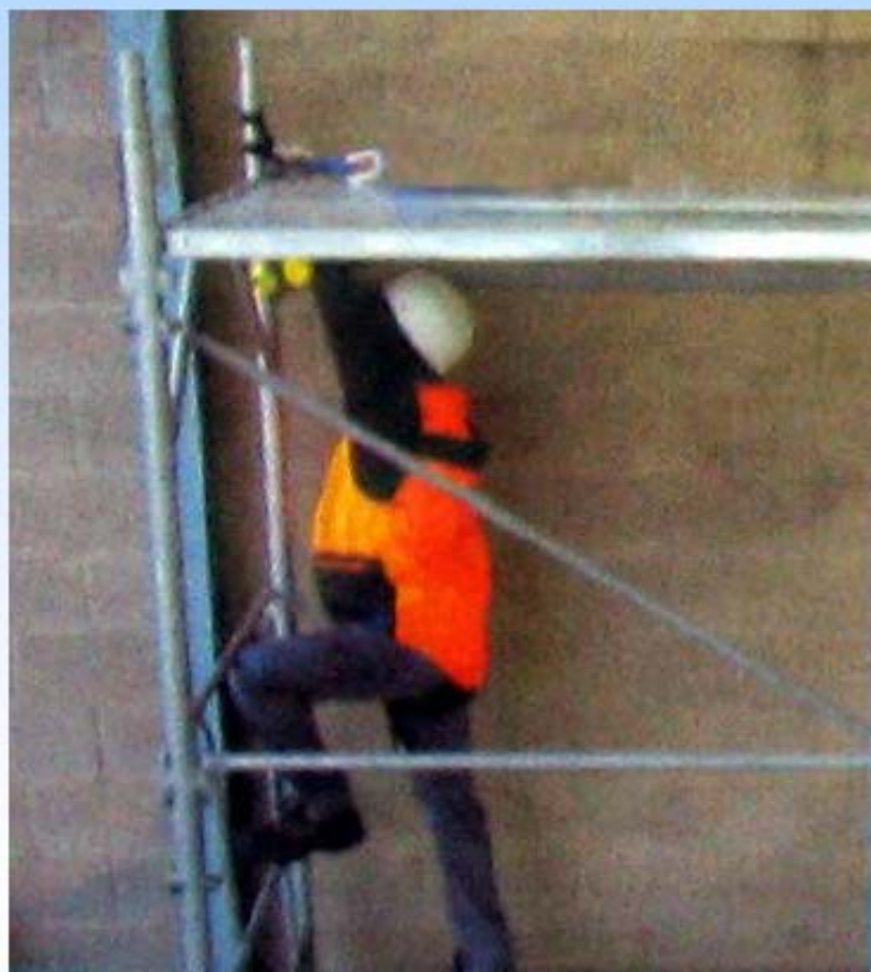
PREDISPORRE L'ANCORAGGIO AD UNA ESTREMITA' DEL PONTEGGIO
